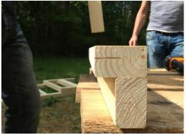
Befestigung an der U-Form (Oberkante des Winkels bei 40,4 cm )
